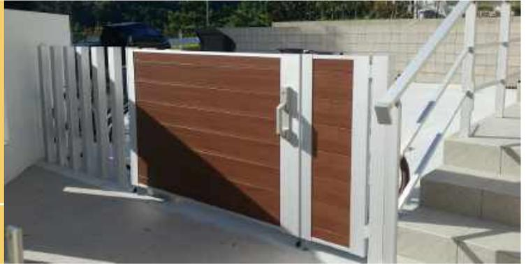
アルミは、錆びにくくメンテナンスの必要があまりない金属です。しかし、表面に付着した汚れを長期間放置すると、腐食の原因となります。それを防ぐには、年数回の水洗いと乾拭きが有効です。
