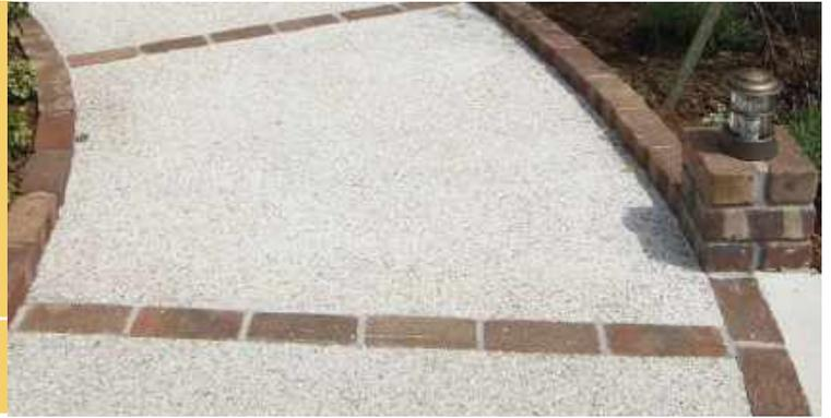
洗い出し仕上げとは古くから受け継がれてきた伝統的な左官工法でセメントに砂利など骨材を混ぜて、固まる前に洗い流し骨材の頭部分を露出させます。この凸凹により、コンクリート仕上げやタイル貼りに比べると、滑りにくいですが、汚れが溜まる可能性があります。定期的なお手入れで汚れを溜めずに綺麗さを保ちましょう。
