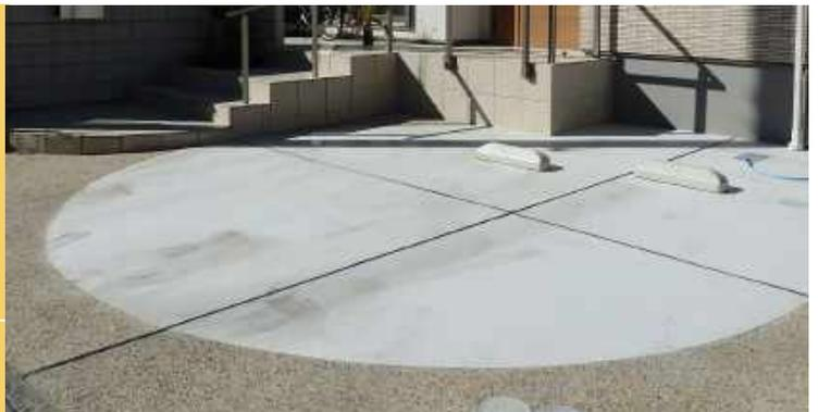
コンクリートが凝結する際の化学反応により生じる熱や打設後の乾燥収縮が原因で、髪の毛程度の太さのひび割れ(ヘアクラック) 生じることがありますが、品質に問題はありません。より太いひび割れが発生した場合は、種々の原因が考えられますので、ご相談ください。
