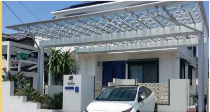
屋根の素材は、ポリカーボネートなどが主に使われています。軽量のプラスチック素材で、衝撃・熱に強く、採光性・耐久性に優れているのが特徴ですが、擦れ傷のつきやすい材質です。定期的なお手入れで美しさを保ちましょう。
